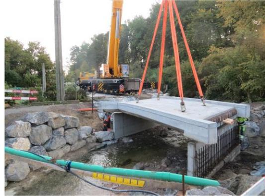
Einpassen der Brückenplatte auf die neuen Widerlager, September 2017
