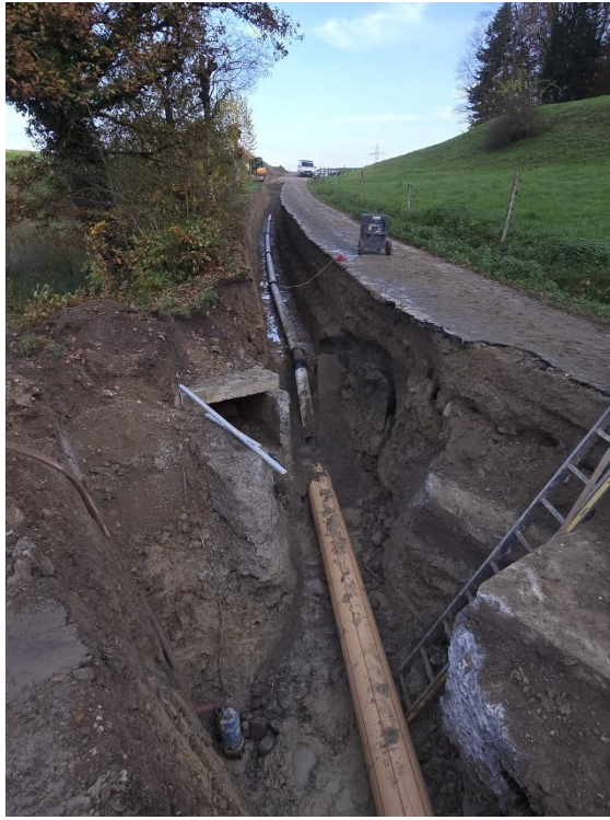
Unterquerung des betonierten Tüftelweiherkanals in der Tüftelstrasse, November 2024
