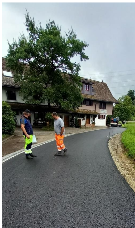
Strassen- und Brunnenmeister beim Besichtigungsrundgang, September 2024
