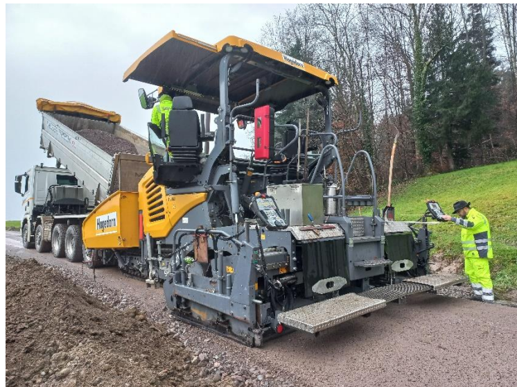
Maschineller Einbau der Kiesausgleichsschicht, November 2024
