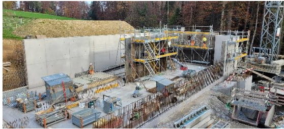
Baumeisterarbeiten für die neuen Durchlaufbecken im November 2024
