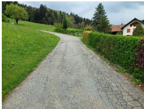
Ausgangszustand Bergstrasse, Bollerrain-Berglegi noch vor dem Bau, Juni 2024
