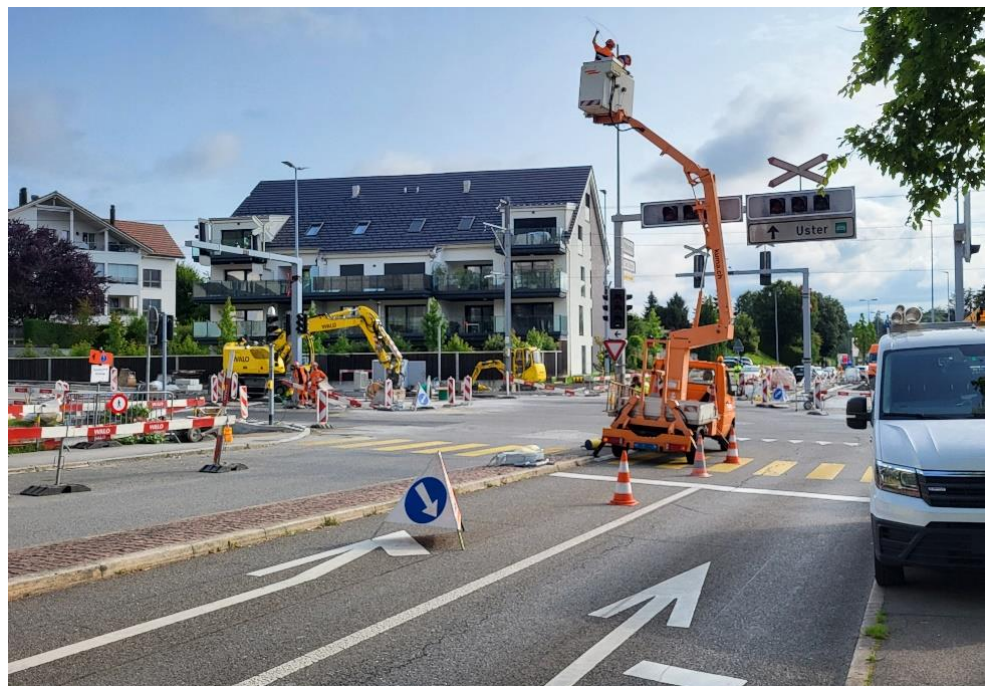
Knoten Forch-/Rällikerstrasse während Bauarbeiten
