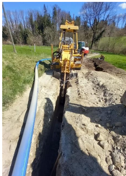
Grabenfräse im Einsatz im Gärtlenweg, April 2024
