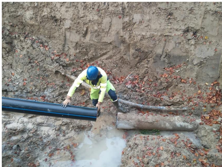
Rohreinzug PE ø 250 mm in die bestehende Transportleitung Eternit ø 300 mm, November 2024
