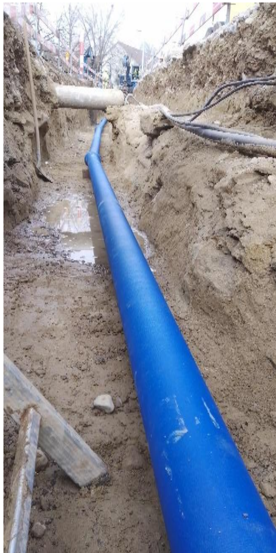
Blick Stufengraben, frisch verlegte Wasserleitung, März 2024
