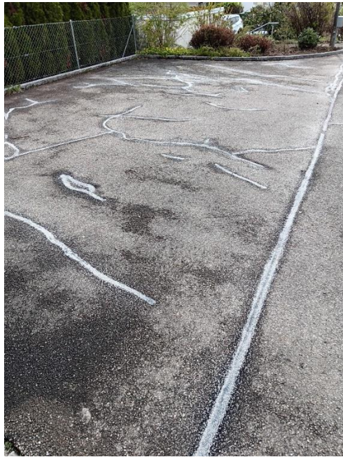
Rissanierung mittels Bitumenemulsion und Quarzsandabstreuerung, April 2024
