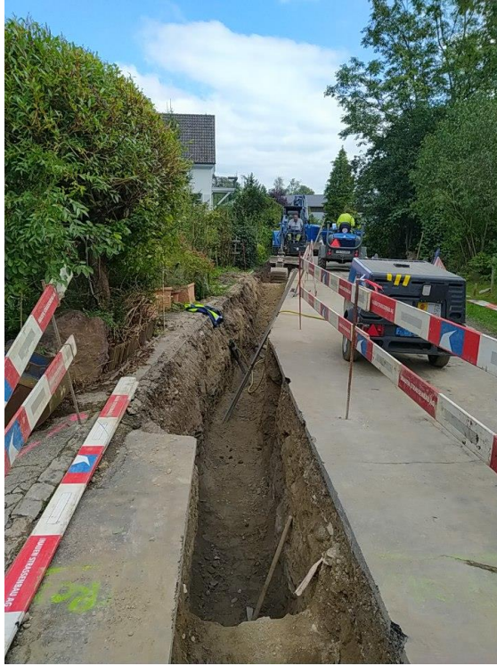
Fertiger Leitungsgraben bereit für die neue Wasserleitung, September 2024
