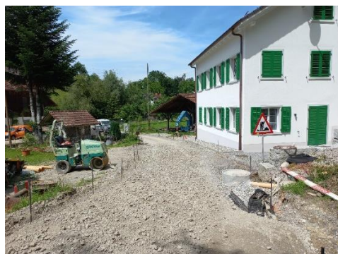
Strassenbereich Hottentalstrasse neu ausgekoffert, Juni 2024
