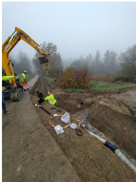
Leitungsgraben entlang der Tüftelstrasse mit der neuen Transportleitung G \varnothing 150 mm, November 2024
