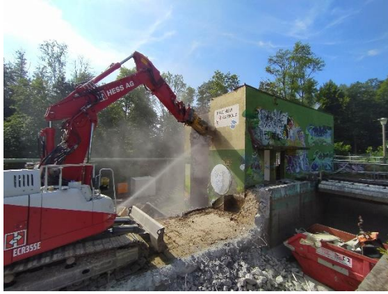
Abbrucharbeiten Betriebsgebäude ehem. ARA Aspholz August 2024
