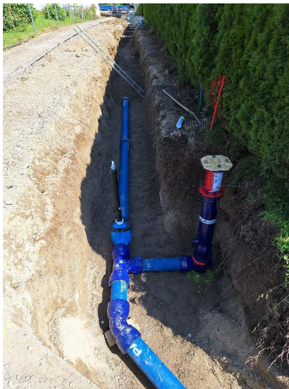
Neu verlegte Transportleitung Guss ø 150 mm mit Hydranten-Abgang und Schieberstange, Juni 2024
