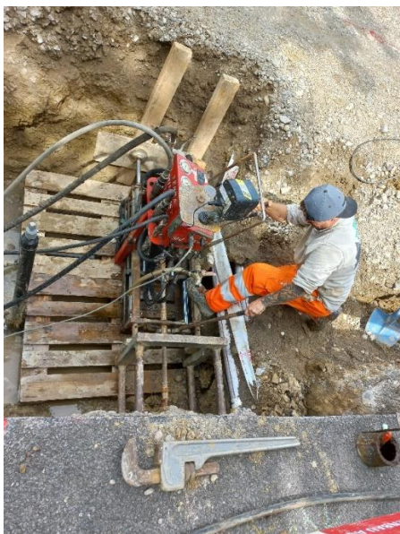
Spülbohrung für die neuen Hausanschlüsse, August 2024
