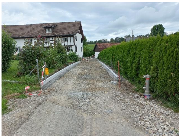
Vorbereitung zur Kiesplanie für den anschliessenden Belagseinbau, August 2024
