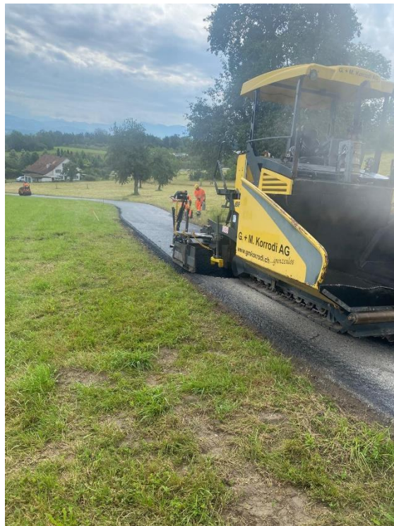
Maschineller Belagseinbau an der Mittlisbergstrasse, Juli 2024
