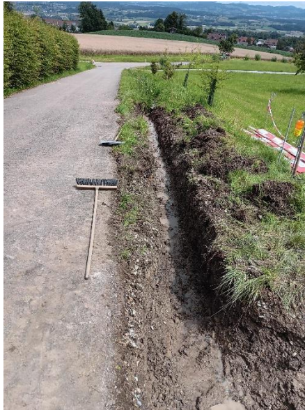
Einbau einer Sickerpackung an der Bergstrasse, Juli 2024
