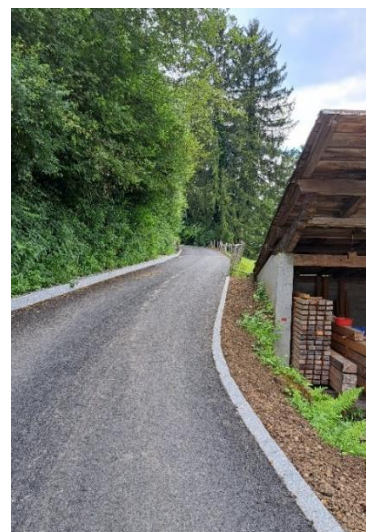
Hottentalstrasse im Endzustand mit neuen Randabschlüssen und frischem Belag, Juli
