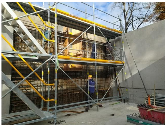
Letzte Armierungsetappe für das Durchlaufbecken 2, November 2024
