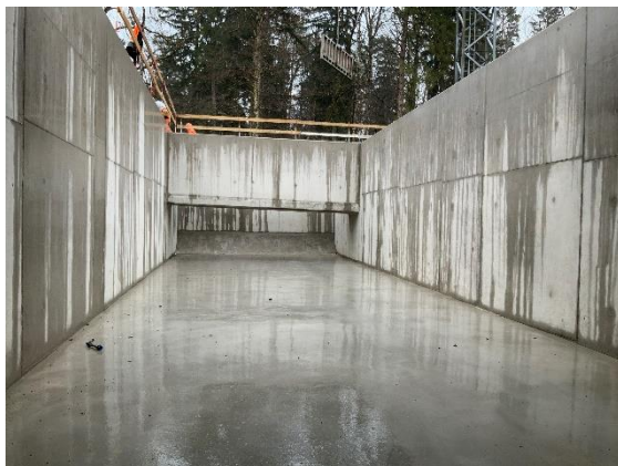
Blick in ein fertig erstelltes Durchlaufbecken der 1. Bauetappe, Dezember 2024
