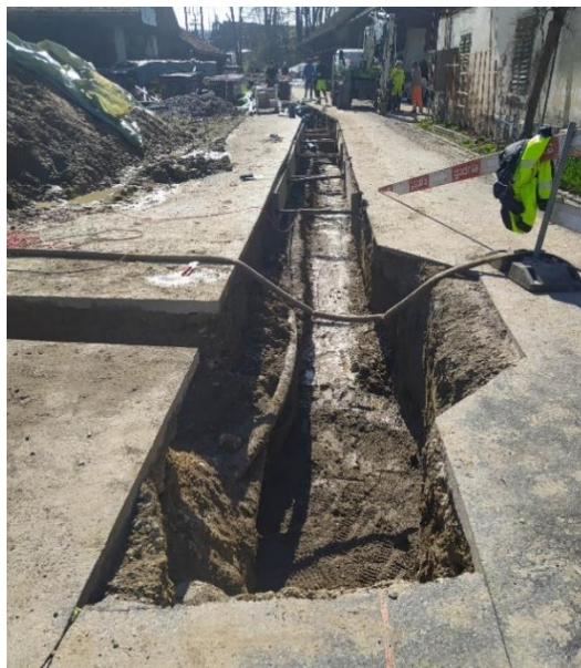
Konventioneller Grabenaushub in der Lieburgerstrasse, März 2024
