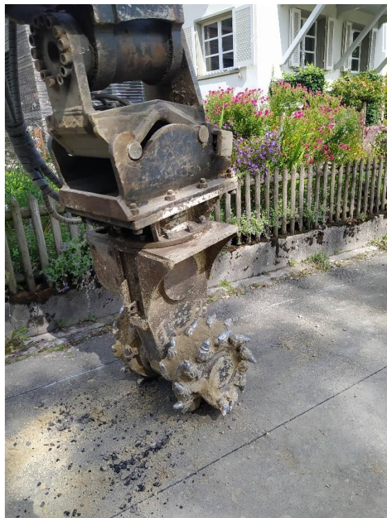
Fräskopf für den Grabenaushub im felsigen Untergrund, September 2024
