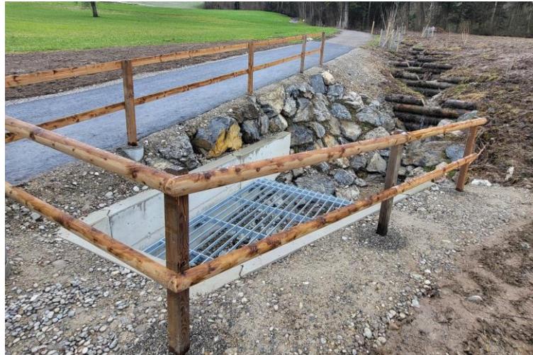
Neuer Einlaufrechen beim Stigelibach
