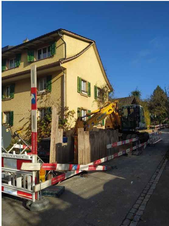
Erfolgter Baubeginn zum Grabenaushub an der Stegstrasse, November 2024
