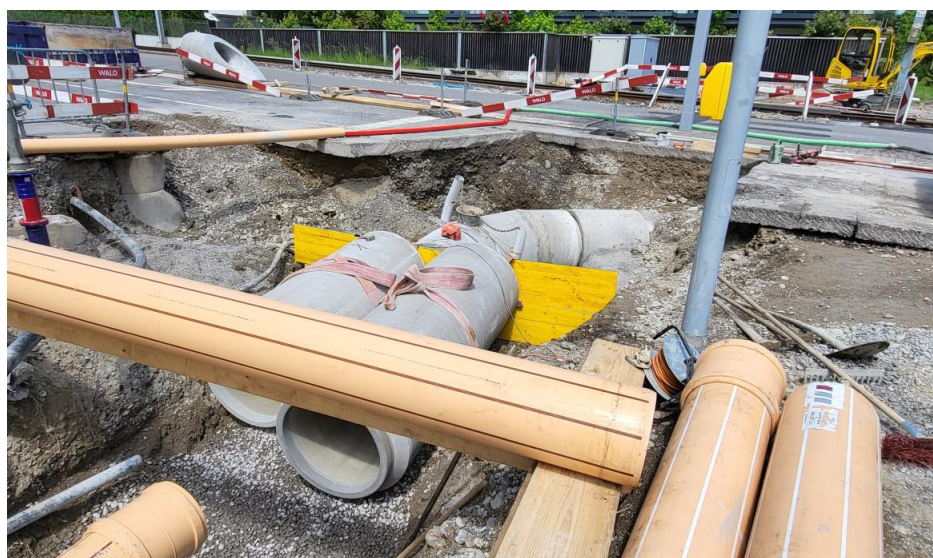
Rohre des Durchlasses Forchstrasse am Bützibach während des Einbaus
