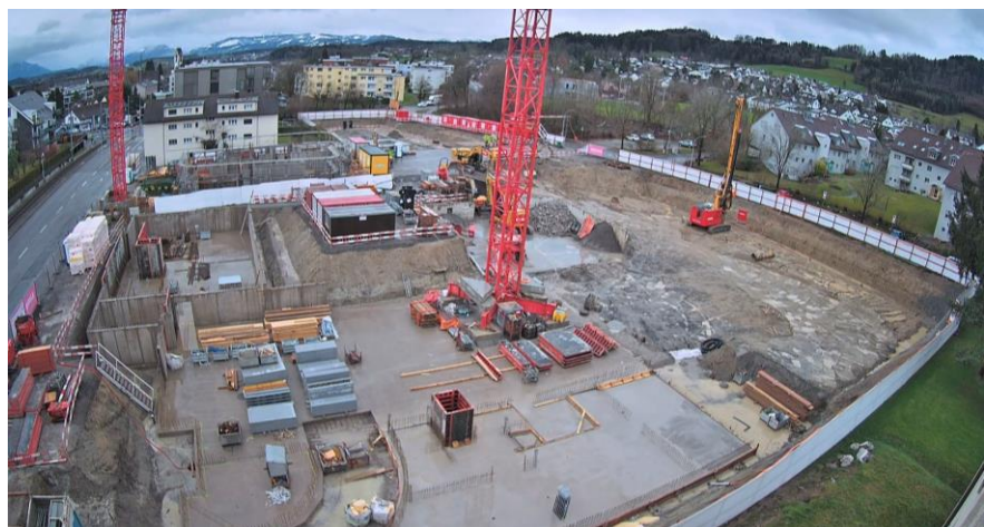
Webcam Baustelle Püntstrasse (aufgerufen am 22. Dezember 2024)
