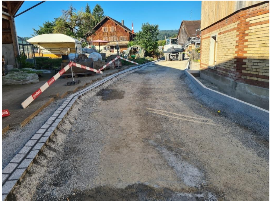
Neue Randabschlüsse und verdichteter Kieskoffer noch vor dem Belageinbau, August 2025.
