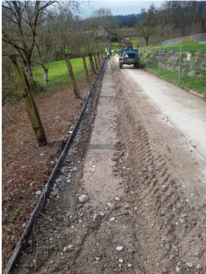
Sicherung der instabilen Strassenschulter mit Winkelementen aus aluverzinktem Stahl mit Geogittereinlage, März 2025.
