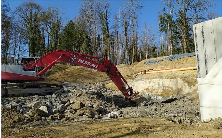
Das alte Fangbecken ist abgebrochen, die letzten Altbetonreste werden abgeräumt, März 2025.
