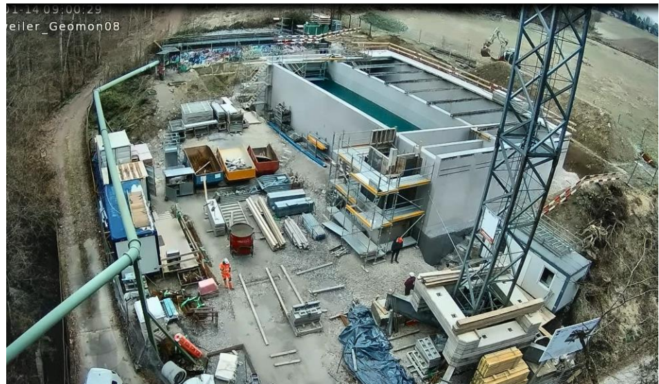
Arbeitsstand mit Beginn des Jahres 2025. Dichtigkeitsprobe der Durchlaufbecken 1+2, Januar 2025.
