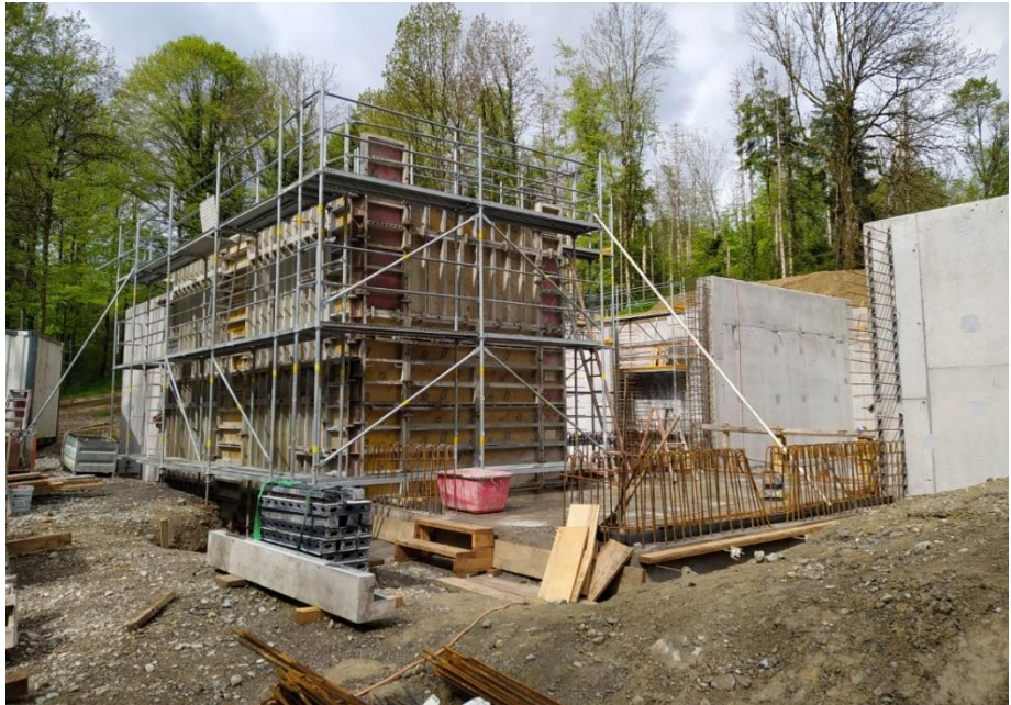
Die vordere Ecke der Seitenwände wird abgeschalt, April 2025.
