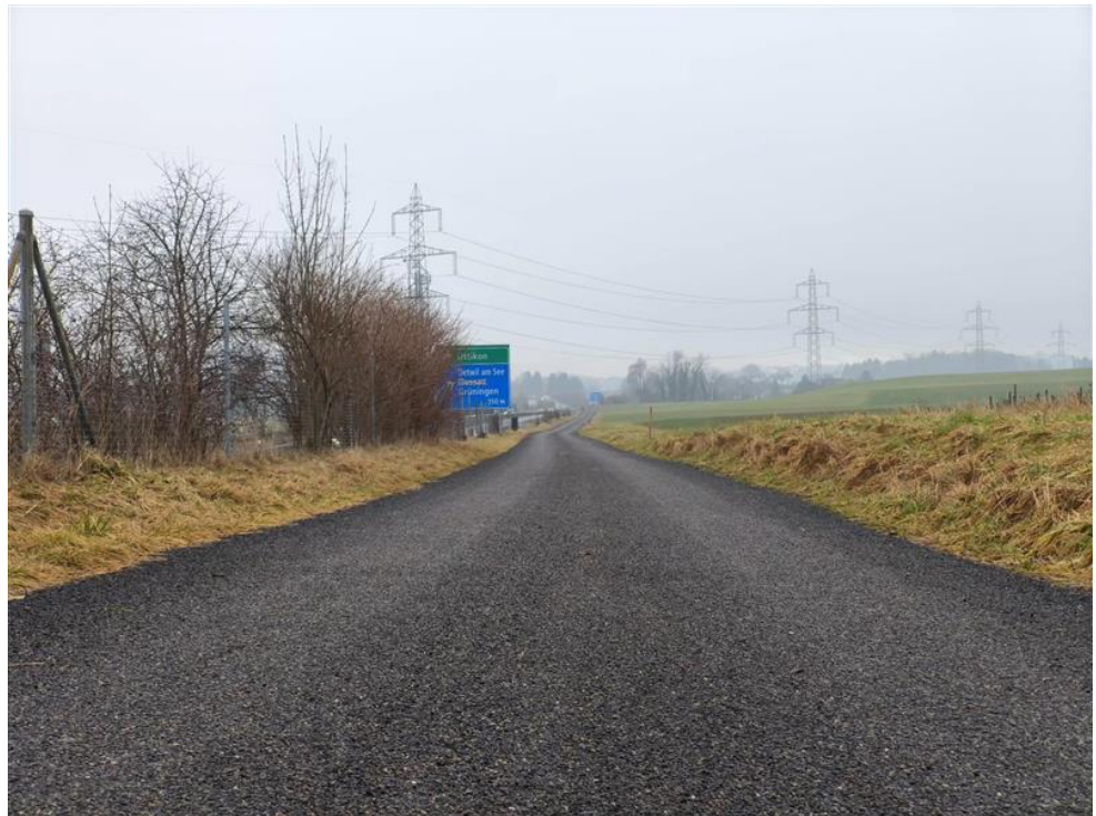
Blick auf die oberflächensanierte Chliweidlistrasse, Februar 2026
