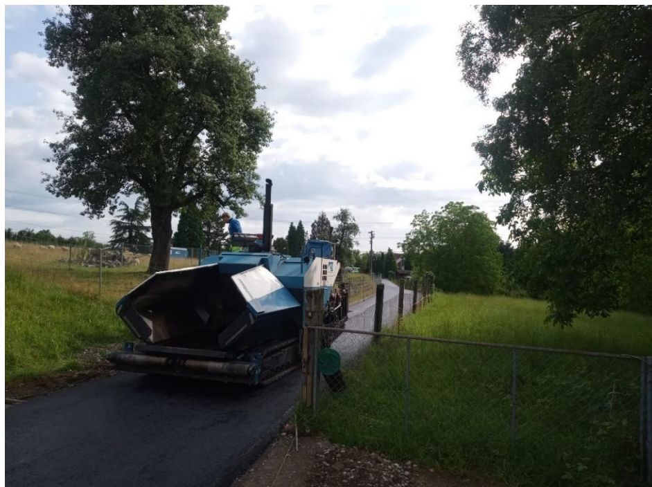
Abschliessender Belagseinbau im Juli 2025.
