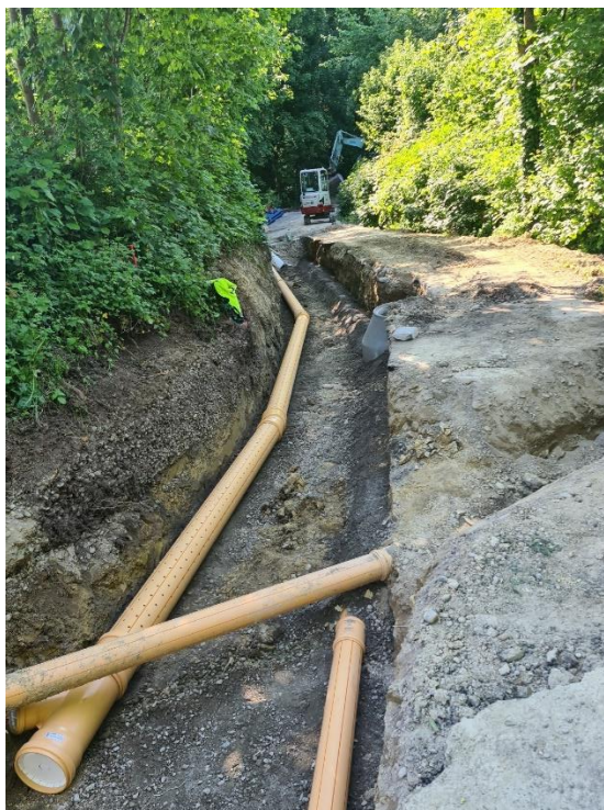
Neubau der Regenabwasser- und Sickerleitung in der Nähe des Lieburgerbach, Mai 2025.
