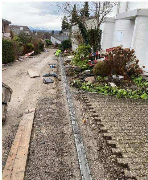
Die neuen Randabschlüsse aus Granit sind bereit für das Verfugen, November 2025
