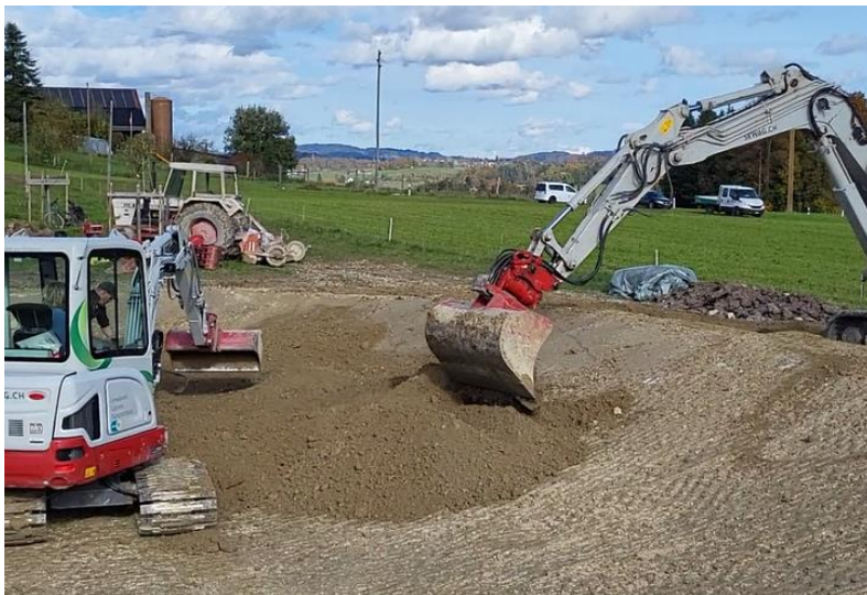
Die Arbeiten zur Abdichtung des neuen Weihers in der Ellenwies, welcher durch das Naturnetz Pfannenstil geplant wurde, während der Bauphase.
