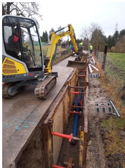
Grabenaushub in der Lesirainstrasse März 2025
