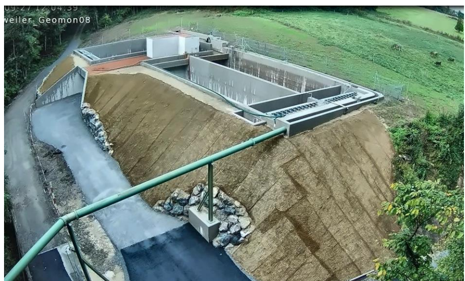
Das Grossbauwerk ist fertig erstellt, Ansicht Webcam, September 2025.
