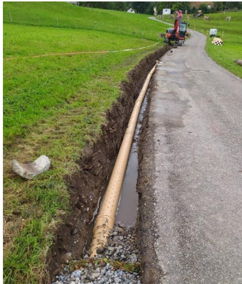
Ersatz der Sickerleitung entlang der Innervollikerstrasse, September 2025
