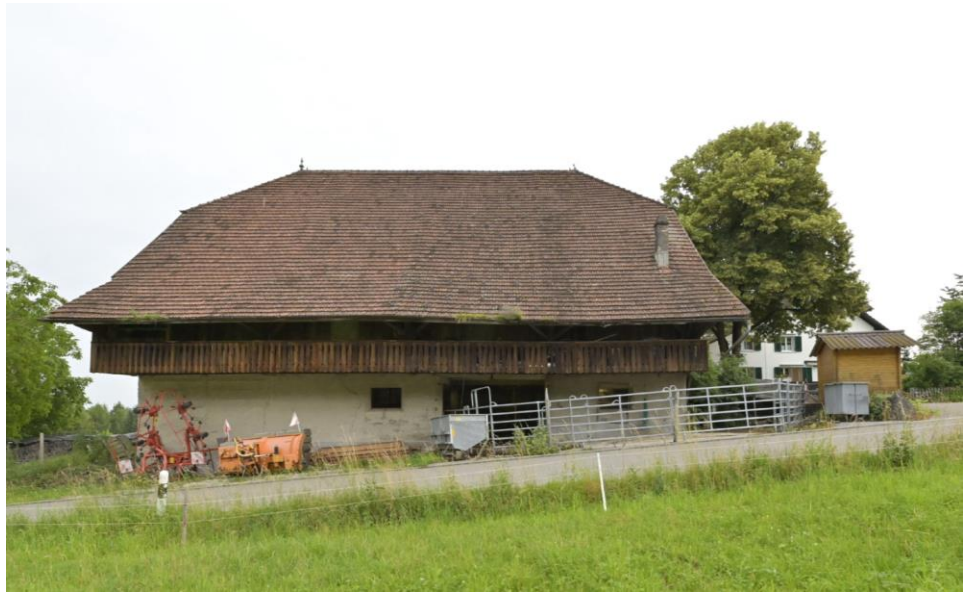
Scheune Underschaubigen 7.2 (Ansicht von Westen)
