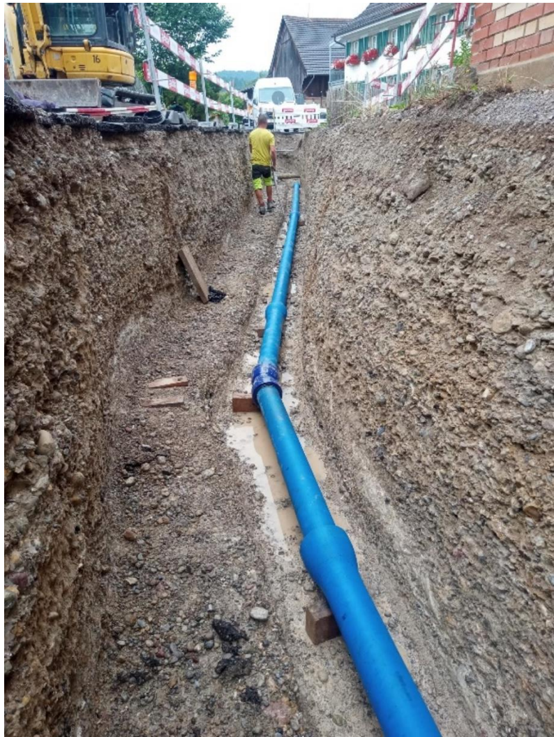
Leitungsgraben für die neue Trinkwasserleitung im wie erwartet hochstehenden Nagelfluh-Fels, Juli 2025
