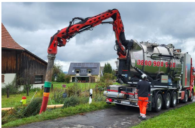
Am Leuenbach wurde im Rahmen des Gewässerunterhalts der Durchlass unter der Bächelacherstrasse mit schwerem Gerät von Aufladungen entfernt.
