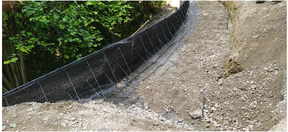
Sicherung der Waldböschung mittels aluverzinkten Stahlgittern und Geogittereinlage, Juni 2025.
