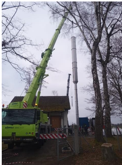
Das neue und über 20 Meter lange Inlinerrohr ist fertig zusammengesetzt und bereit für den Einbau, Dezember 2025.
