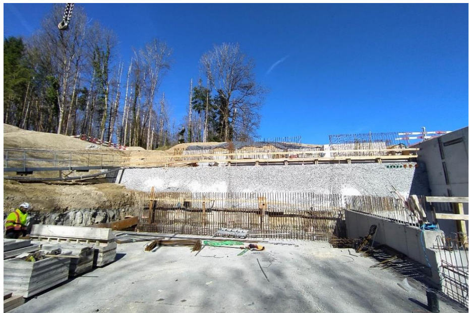
Die Bodenplatte ist betoniert, die Anschlussarmierungen für die ersten Seitenwände stehen bereit, April 2025.
