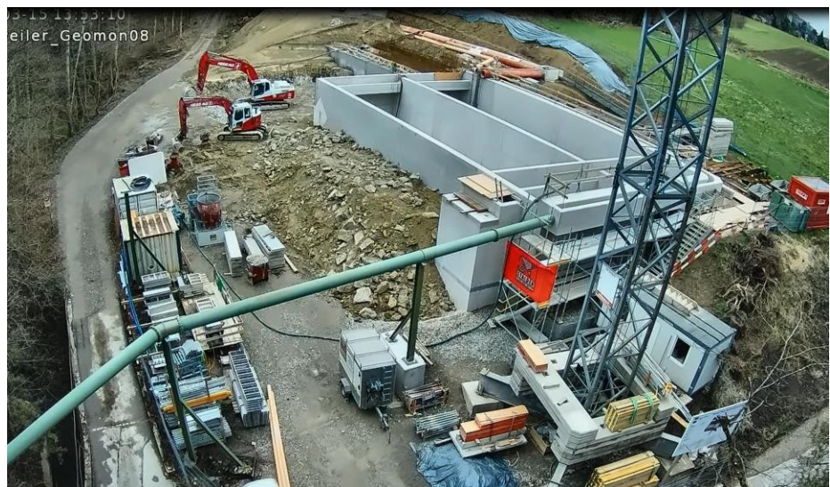
Die Hochleitung ist umgelegt. Im Hintergrund findet der Abtrag für das neue Fangbecken statt, Ansicht von schräg von oben ab der Webcam über der Alten Zürichstrasse, März 2025.
