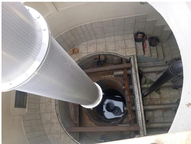
Absenken des neuen Inlinerrohr - sichtbar die unteren Wickeldrahtfilter - welche in den bestehenden Grundwasserbrunnen eingelassen werden, Dezember 2025
