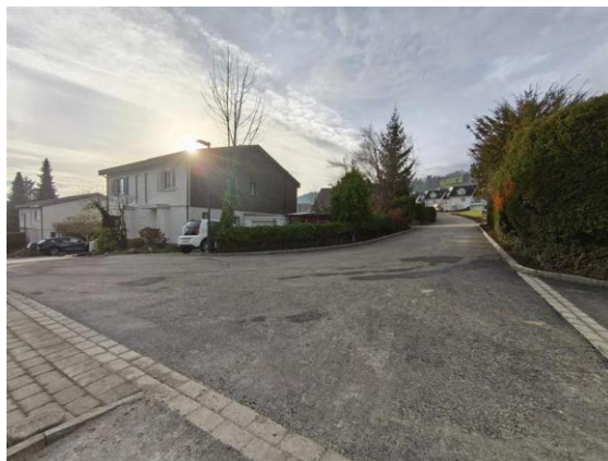
Blick in die Quartierstrasse nach der erfolgten Gesamtsanierung, Dezember 2025
