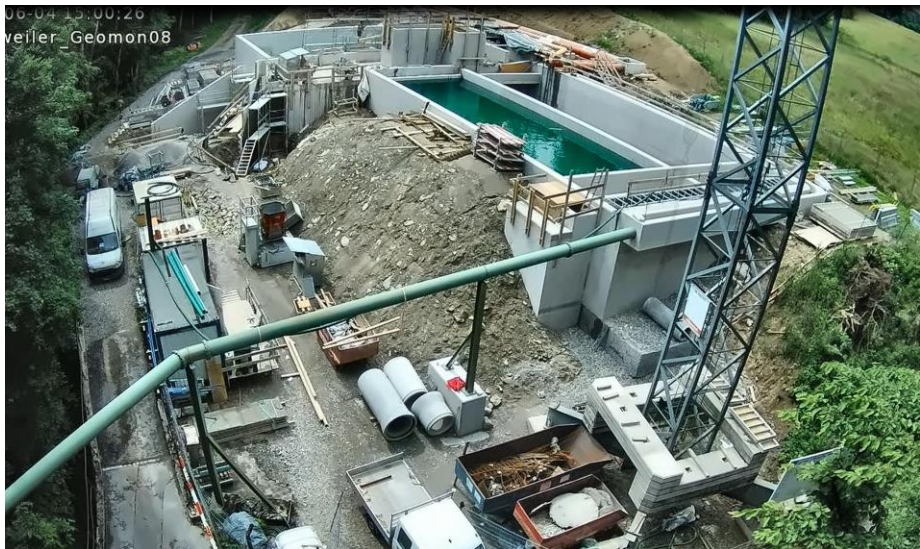
Die Zugangspartie mit den schrägen Seitenflügeln wird erstellt, April 2025.
