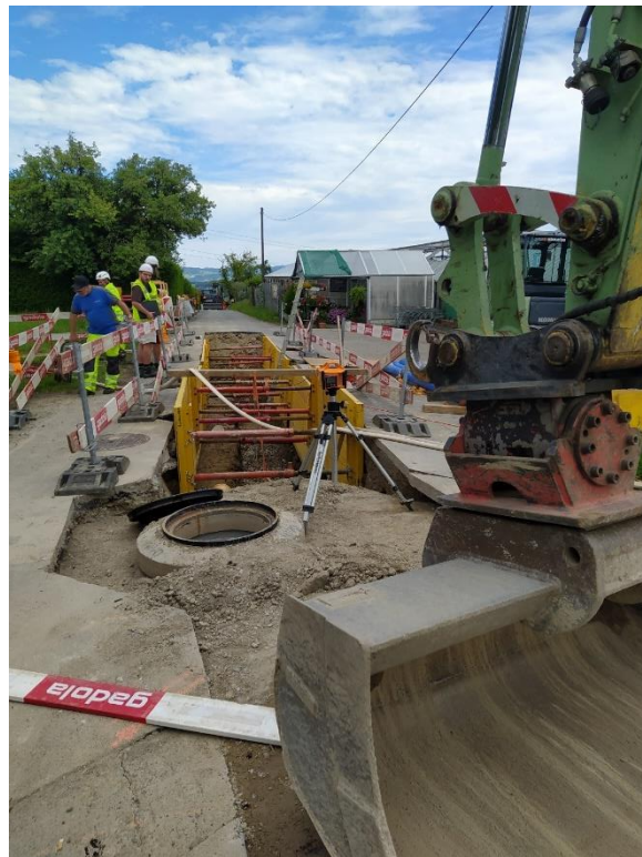
Grabenbereich für die neue Regenabwasserleitung, September 2025
