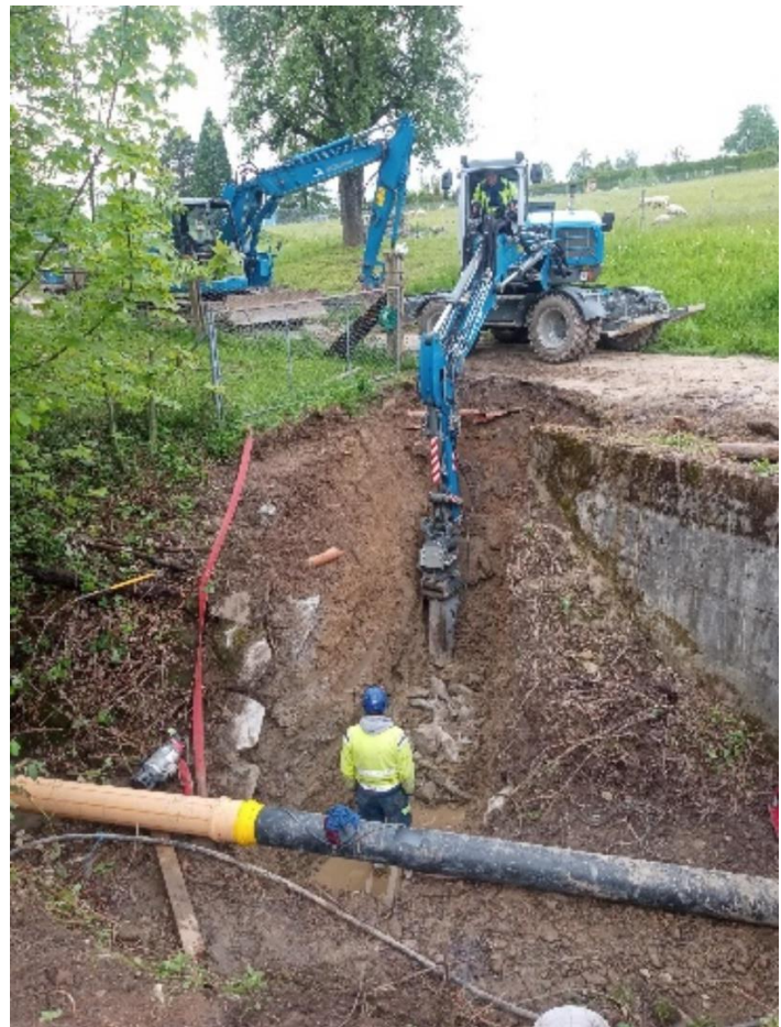
Grabenaushub für die neue Wasserleitung zur Unterquerung des Stirzenbach, Mai 2025.
