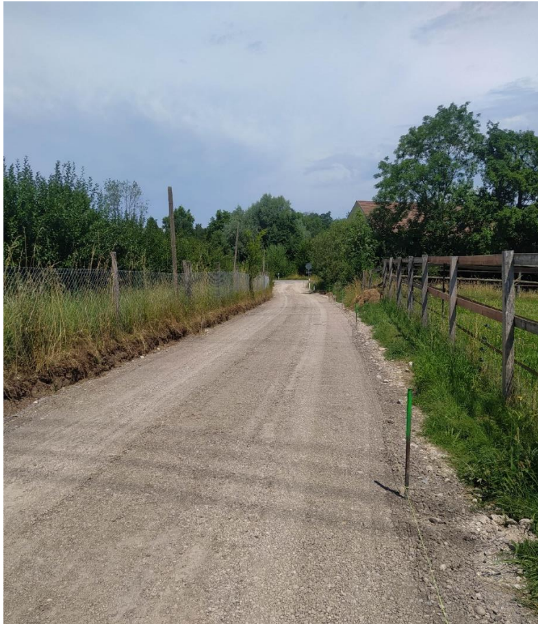
Die Kiesplanie ist bereit für den abschliessenden Belagseinbau, Blick Richtung Sandgrueb, Juli 2025.
