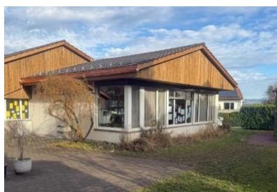
Kiga Sonnenhof nach Sanierung
