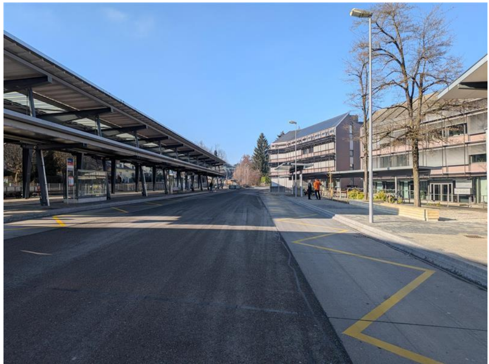
Haltekanten Esslingen nach Abschluss der Bauarbeiten
