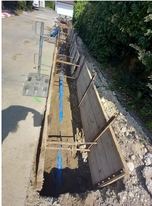
Die neue Versorgungsleitung ist eingesandet und kann nach dem Einmessen ganz eingedeckt werden, August 2025
